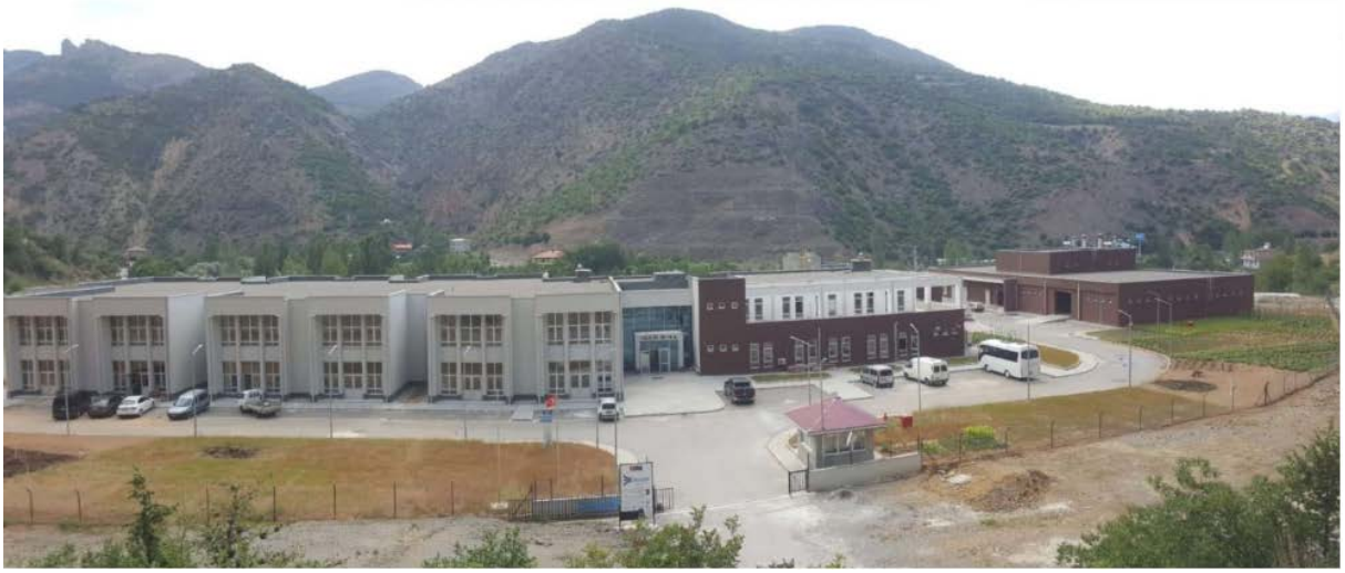
Şekil 1 Gümüşhane İŞGEM Genel Görünümü
